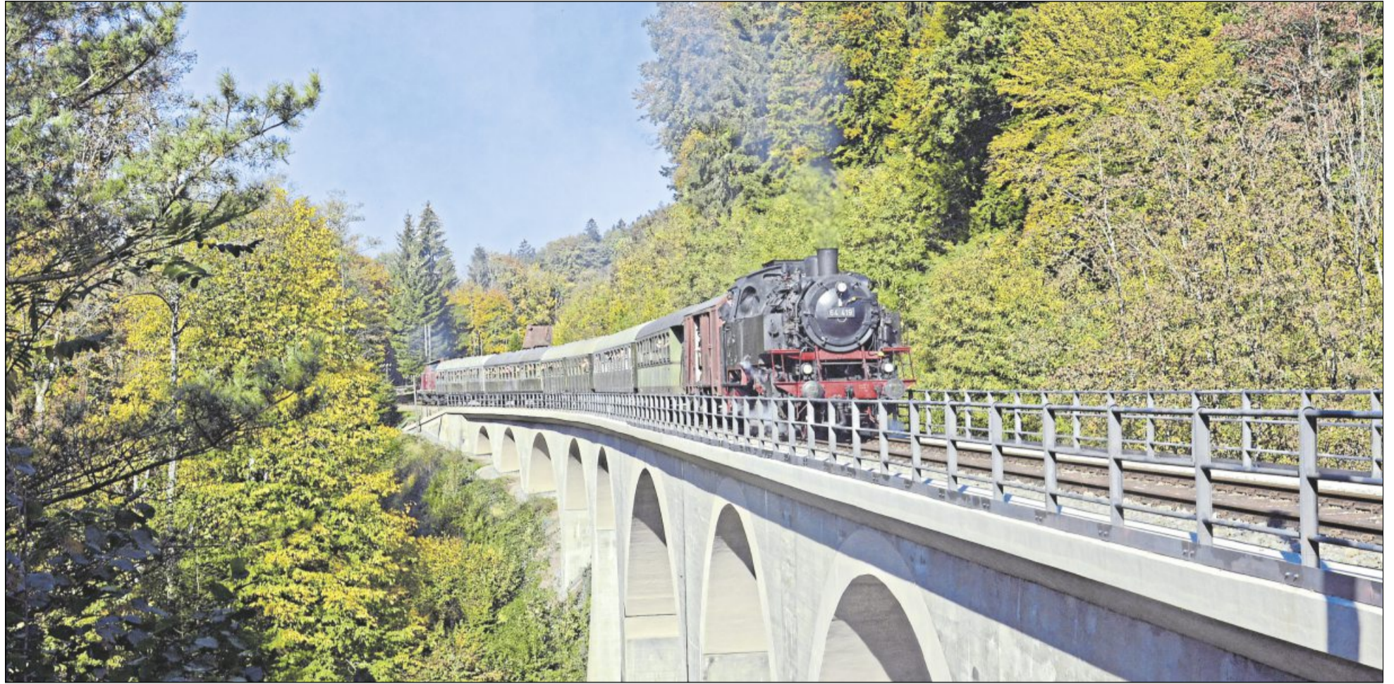
Oktober 2018: Der Dampfzug fährt erstmals über das frisch sanierte Viadukt Laufenmühle.
