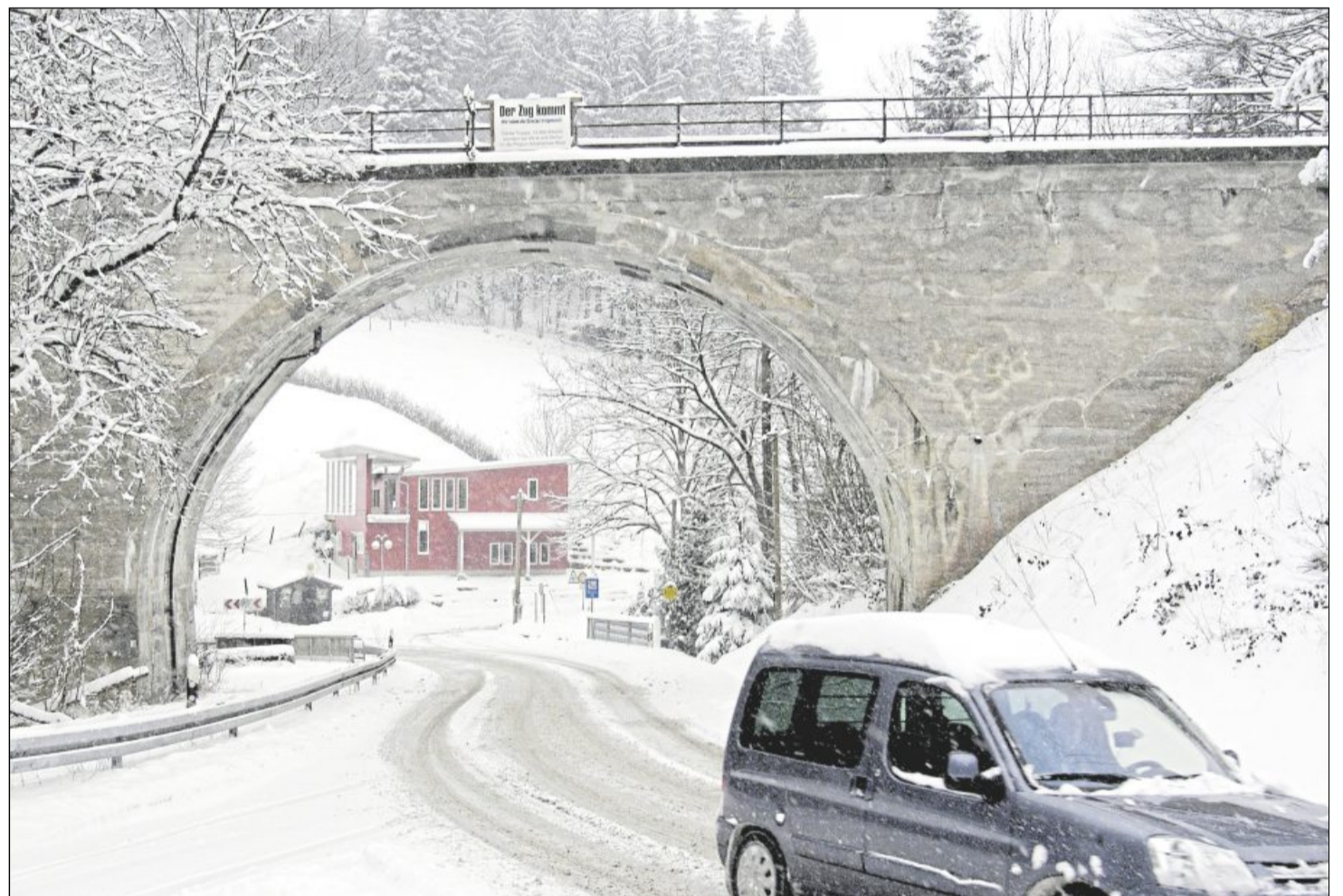
Das Viadukt Laufenmühle im Januar 2007 im unsanierten Zustand.
