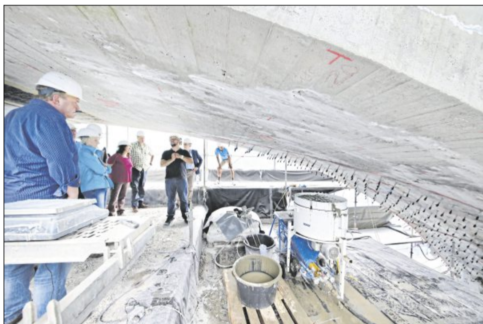
Im August 2018 besichtigte der Welzheimer Gemeinderat die Baustelle.
